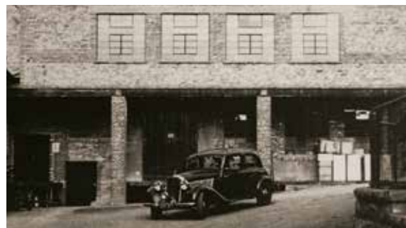
Produktionshalle in den 50er Jahren · Production hall in the 50s.
